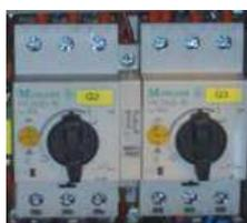
Рис.1. Автомат электродвигателя
