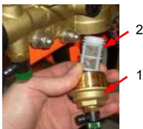
Рис. 81: Грязеулавливающая сетка
